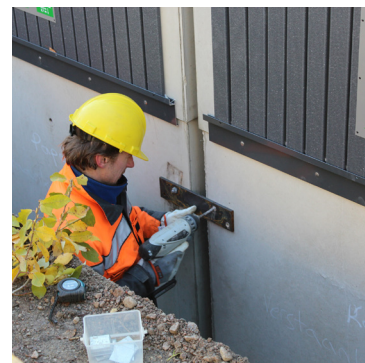
Kuva 6. Runkokaivojen sidonta toisiinsa
