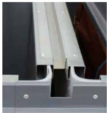
Kuva 2. U-listan kiinnitys
