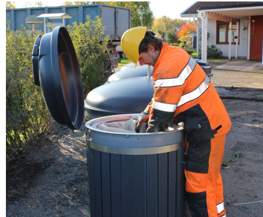
Kuva 3. Säkkien avaaminen, suoristaminen ja paikalleen laitto
