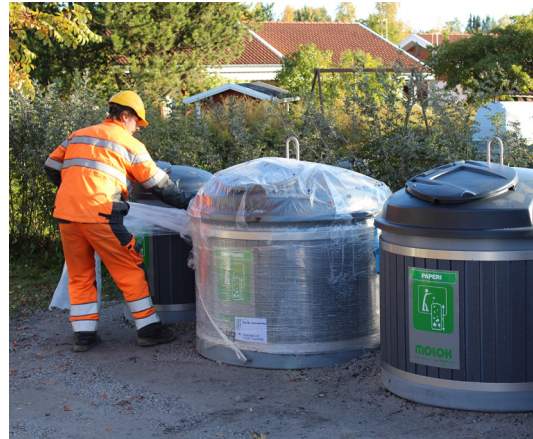
Kuva 1. Suojamuovien poisto
