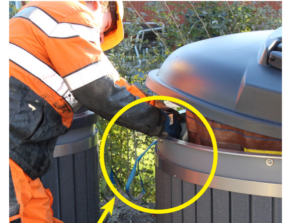
Kuva 2. Nostolenkkien poisto
